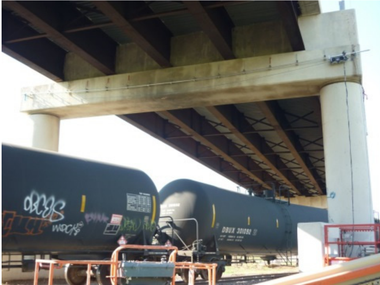
Bild 13: Untersuchung von Brückenträgern mit parabolisch verlaufenden Spanngliedern.
