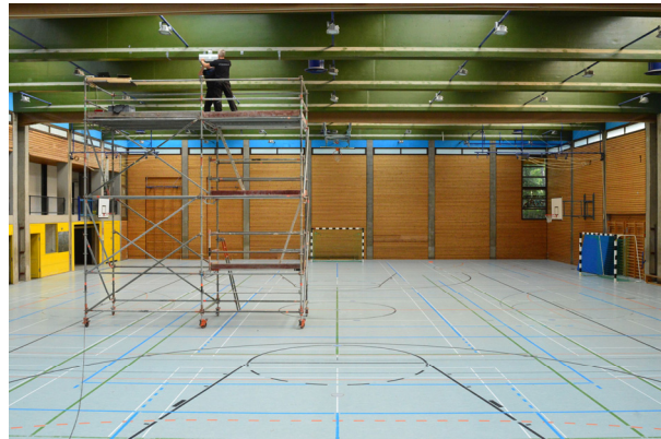
Bild 10: Untersuchung von Spannbetonbindern einer Sporthalle.
