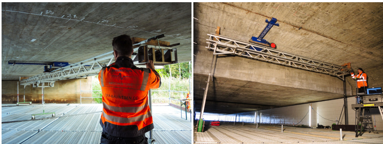
Bild 5: Untersuchung von vorgespannten Brückenflächen mit der BlueOne (3m Sensoreinheit)
