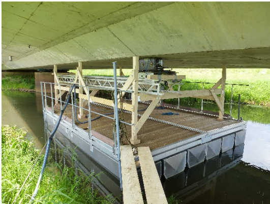
Bild 9: Untersuchung einer Spannbetonbrücke mit Hilfe einer schwimmenden Plattform.
