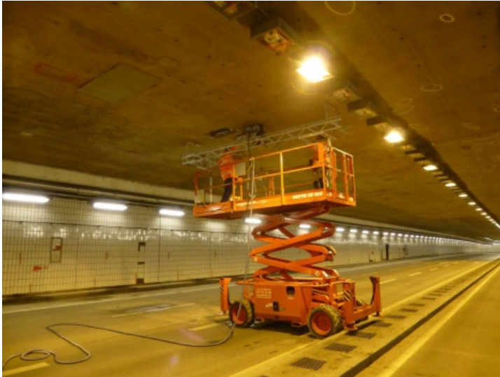
Bild 7: Untersuchung einer Tunneldecke.
