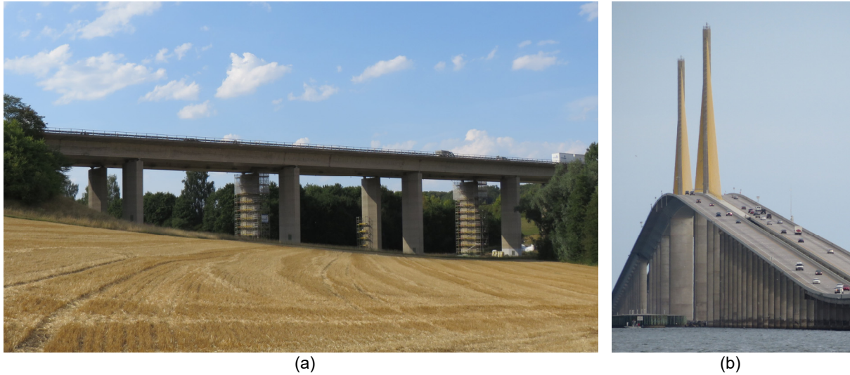
Bild 16: Autobahnbrücken in Spannbetonbauweise. Untersucht wurden die in der Brückenplatte liegenden Querspannglieder, welche durch die Verwendung von Tausalzen stark korrosionsgefährdet sind (a: Schüpfbachtalbrücke BAB A 81, b: Sunshine Skyway Bridge Florida/USA).
