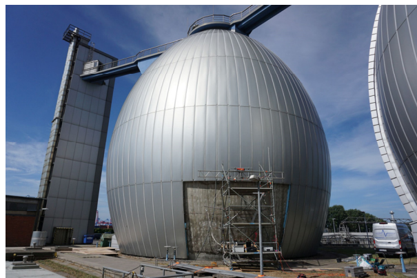
Bild 12: Untersuchung von Spanngliedern eines Faulbehälters.
