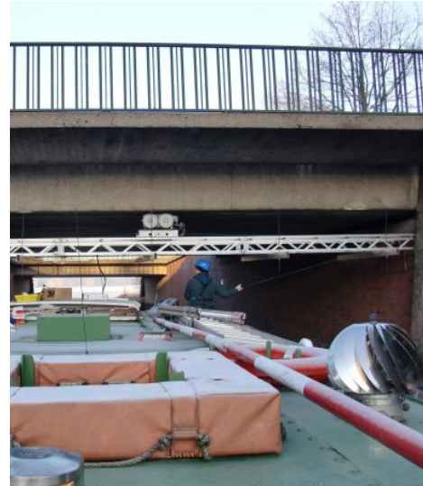
Bild 8: Untersuchung von Brückenträgern.
