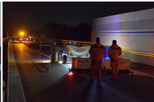
Bild 18: Untersuchung der Fahrbahnplatte einer Autobahnbrücke an der BAB A 81.
