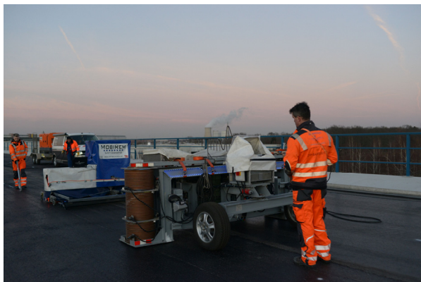
Bild 17: Untersuchung der Fahrbahnplatte einer Autobahnbrücke in Wolfsburg.
